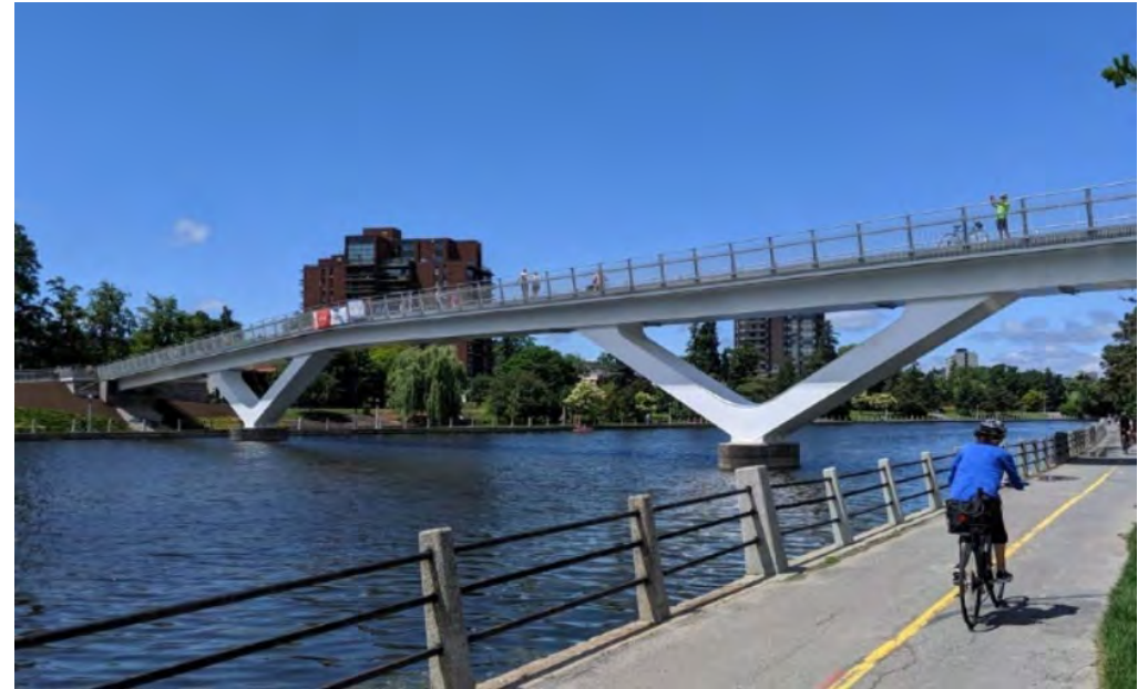
Flora Footbridge, Ottawa – CSA S7 Annex B
